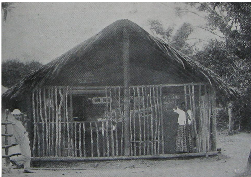
Figura 6. Barraca de taipa e cobertura de palha de ubuassú. Fonte: ARAÚJO, Heraclides Cesar de Sousa. A Prophylaxia Rural no Estado do Pará . Belém: Tipografia da Livraria Gillet, 1922.
