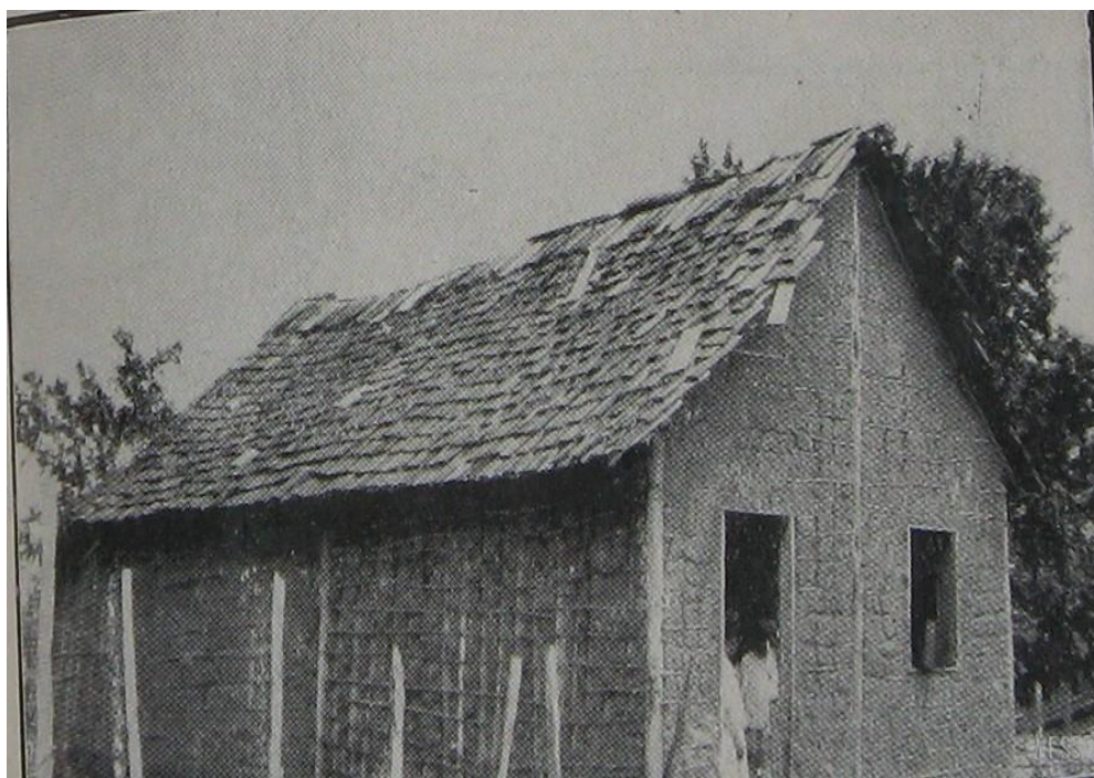
Figura 7. Barraca de taipa com cobertura de cavaco. Fonte: ARAÚJO, Heráclides César de Sousa. A Prophylaxia Rural no Estado do Pará . Belém: Tipografia da Livraria Gillet, 1922.
